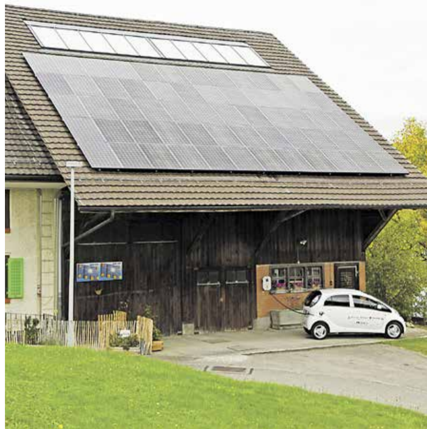
Hausdach mit grosser Photovoltaikfläche.
